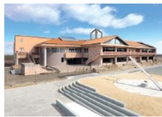
震災遺構中浜小学校 (山元町)
