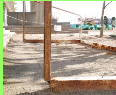
根元が腐食したゴールポスト→
