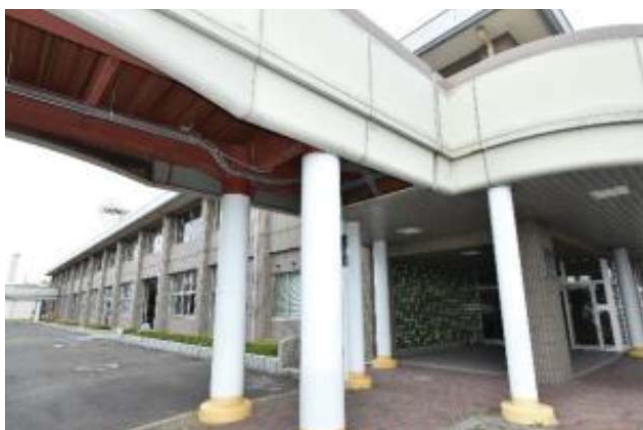
④ 4号館実習棟（運動場側から撮影）
