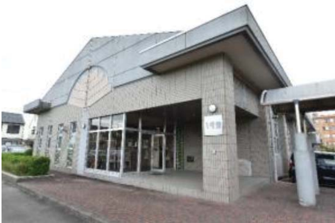
① 1号館実習棟（運動場側から撮影）
