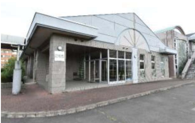
② 2号館実習棟（運動場側から撮影）
