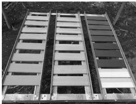
写真－1 架台設置状況
