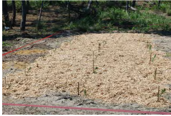
図－5 砂の移動を抑止するためのマルチング施行
