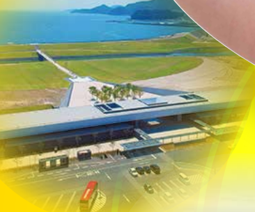
東日本大震災 津波伝承館 (岩手県)
