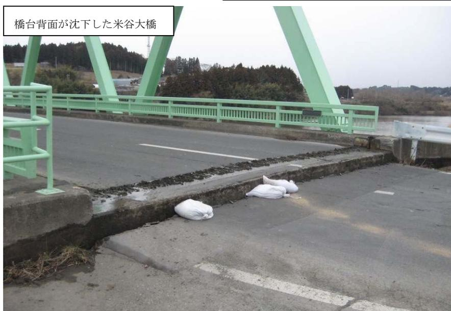
橋台背面が沈下した米谷大橋
