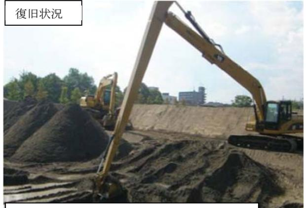
仙塩浄化センター 沈殿池汚泥撤去状況
