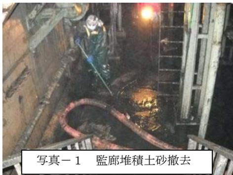
写真-1 監廊堆積土砂撤去
