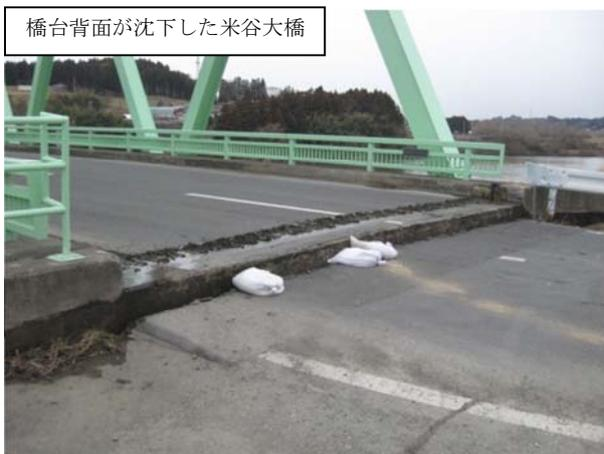
橋台背面が沈下した米谷大橋
