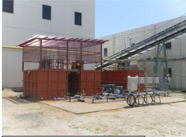
写真-4 仮設汚泥処理施設設置
