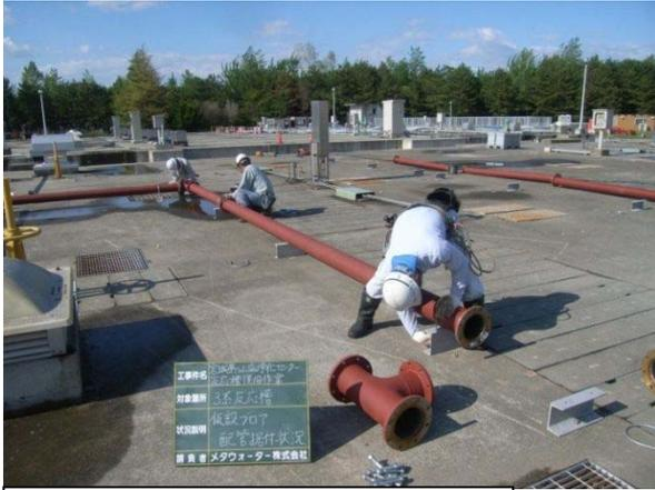
写真-3 簡易曝気設備設置状況
