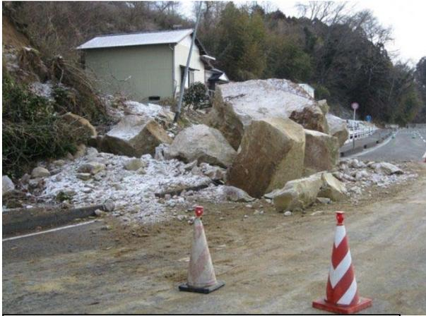
写真-1 (一) 若柳築館線の落石による通行規制
