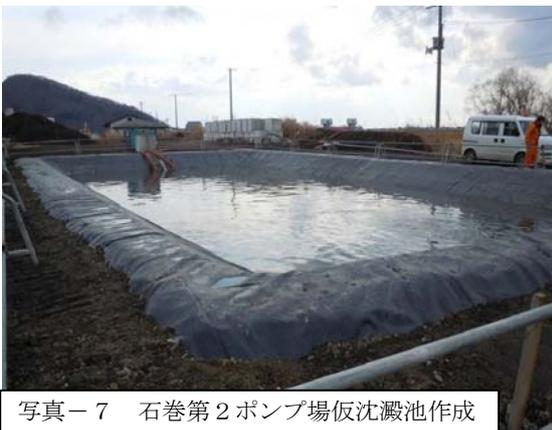
写真-7 石巻第2ポンプ場仮沈澱池作成
