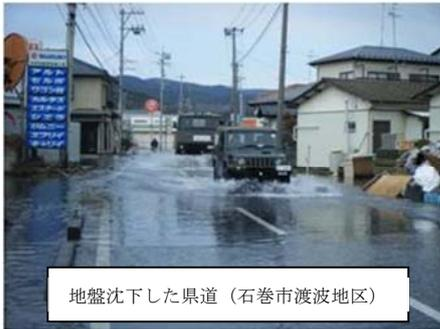
地盤沈下した県道（石巻市渡波地区）
