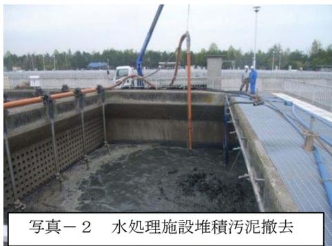
写真-2 水処理施設堆積汚泥撤去
