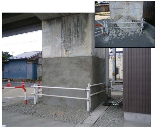
写真-4 川南高架橋の応急復旧状況
