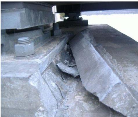
写真-3 小田ダム取水塔管理橋被災状況
