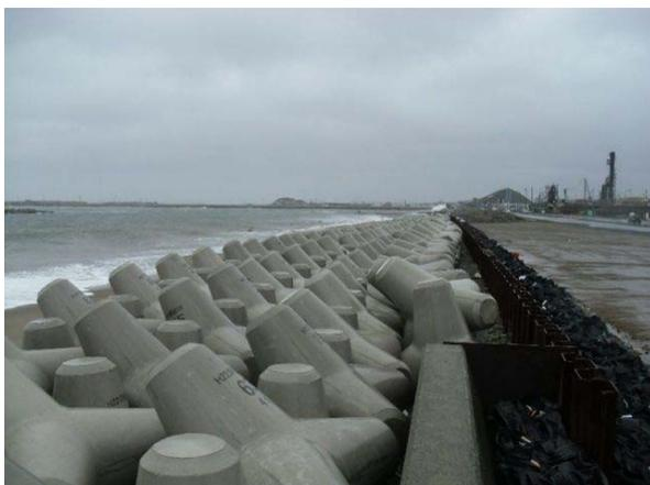
写真-5 東浜防潮堤応急対応の状況
