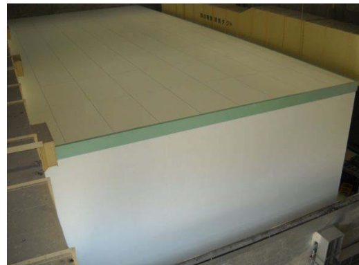
▲新電気室施工後
