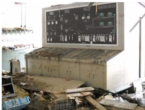
▲監視装置施工前
