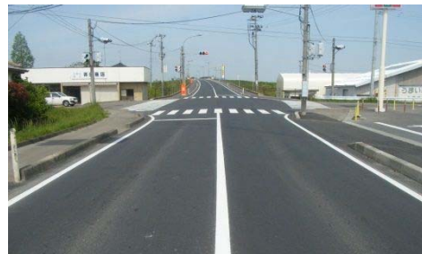
▲石巻鹿島台大衡線二郷外道路
