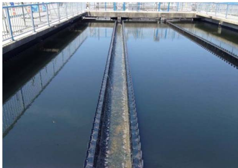
▲第4系列最終沈殿池復旧・処理状況
