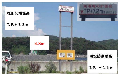
▲復旧高さ標示板設置
