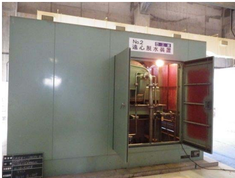
▲汚泥処理試運転状況
