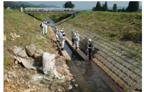
▲災害査定状況
