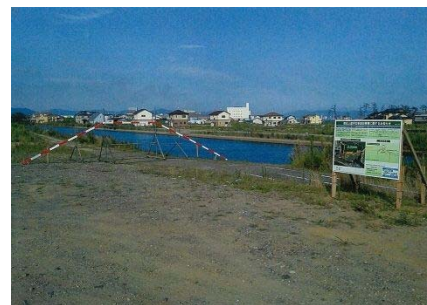
▲看板及び丁張り設置(8/10)
