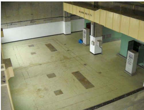
▲新電気室施工前
