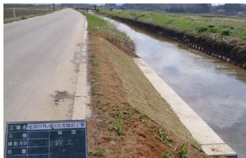
▲尾袋川（角田市小田）復旧後
