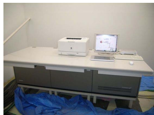
▲監視装置施工後
