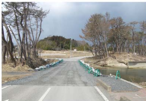
▲災害復旧応急工事完了後
