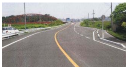
▲(国)349号(角田市江尻深沼)復旧後
