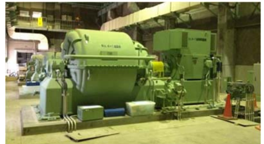
▲送風機設備復旧完了
