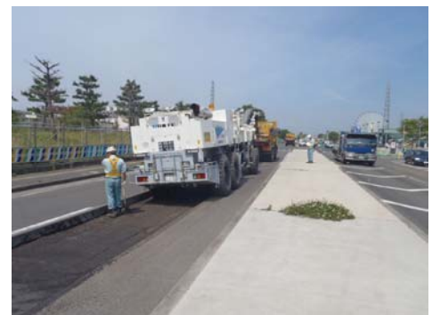
▲ふ頭5号線路面切削
