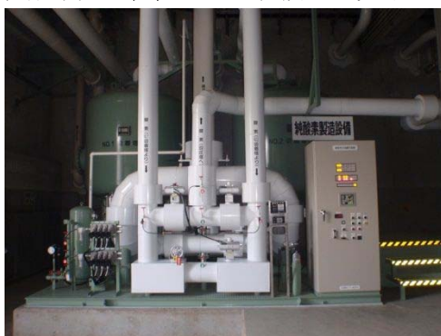
▲純酸素発生装置試運転調整完了
