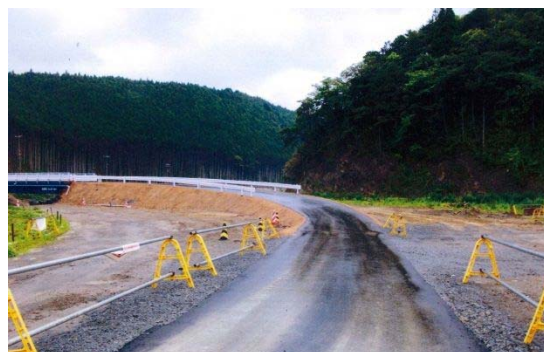
▲西戸橋復旧後
