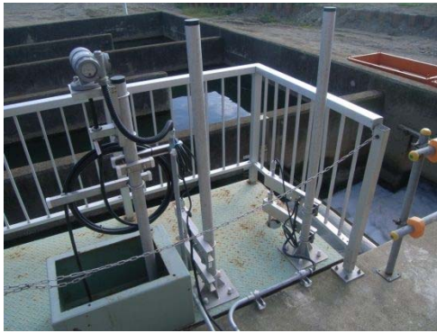
▲放流水質測定装置設置状況
