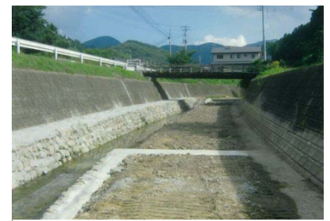
▲砂防流路改良工事
