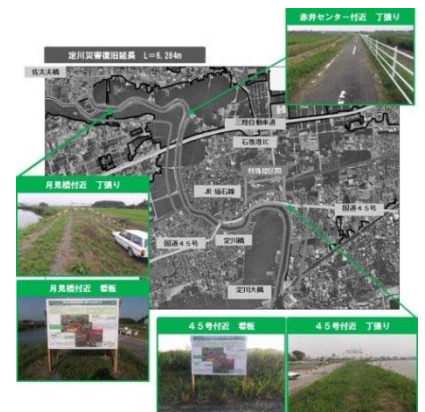
▲看板及び丁張り設置 (7/10)
