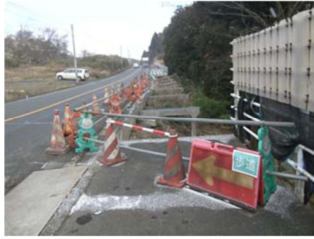
▲(主)古川佐沼線 迫町北方 被災状況
