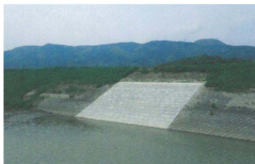
▲齋川(白石市大平森合)復旧後
