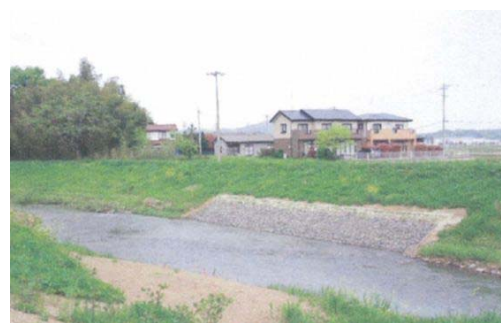
▲齋川(白石市大平板谷①)復旧後
