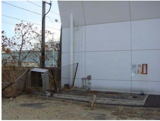
▲オイルタンク着工前
