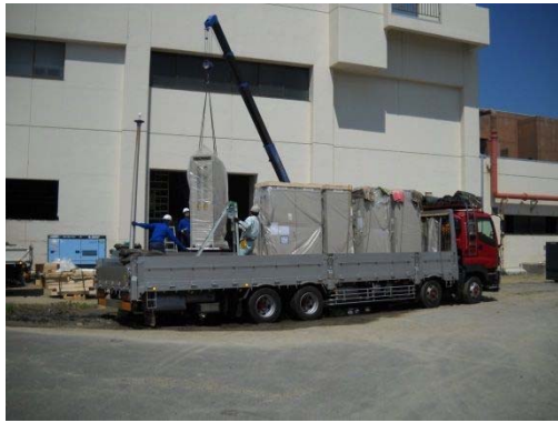
▲機器搬入状況
