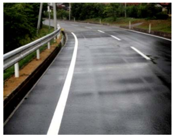
▲本復旧工事完了後
