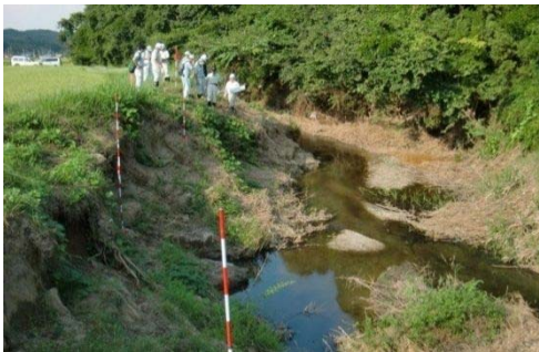
▲災害査定状況
