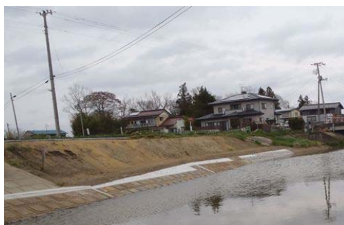
▲尾袋川（角田市佐倉①）復旧後
