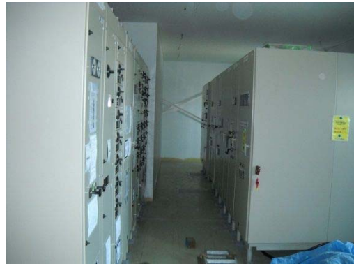
▲機器設置完了
