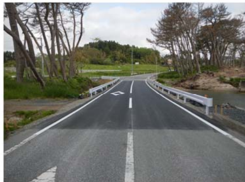
▲仮舗装工事完了後
