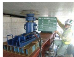
▲鉛直用 200ton ジャッキ
