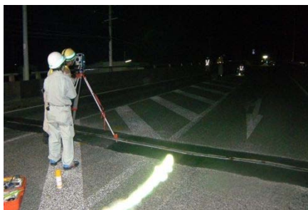
▲道路法線の確認
