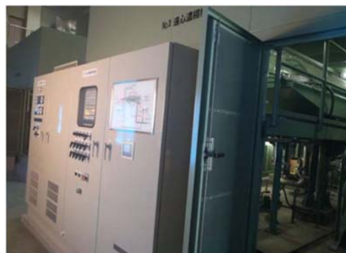
▲機械濃縮設備復旧完了
