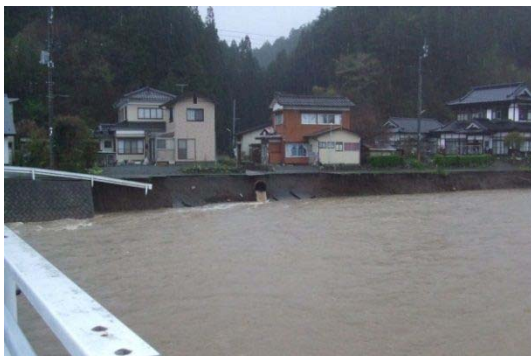
▲被災状況（5月4日）
