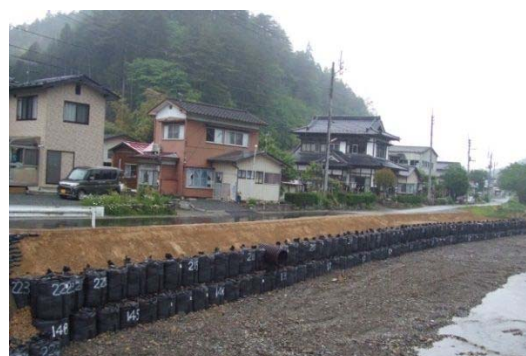
▲応急復旧完了（5月28日）
