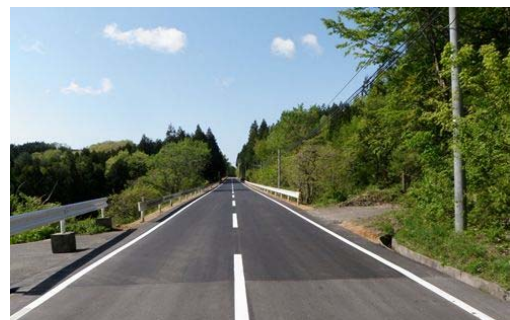
▲(国)457号 (川崎町本砂金②) 復旧後
