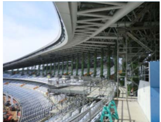
仮説柱の施工状況
