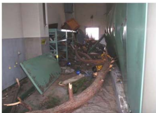
▲機械濃縮設備被災後
