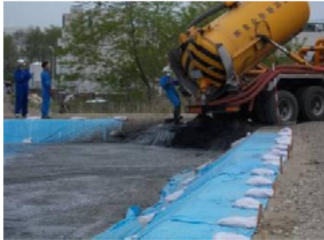
写真4 汚泥運搬作業
