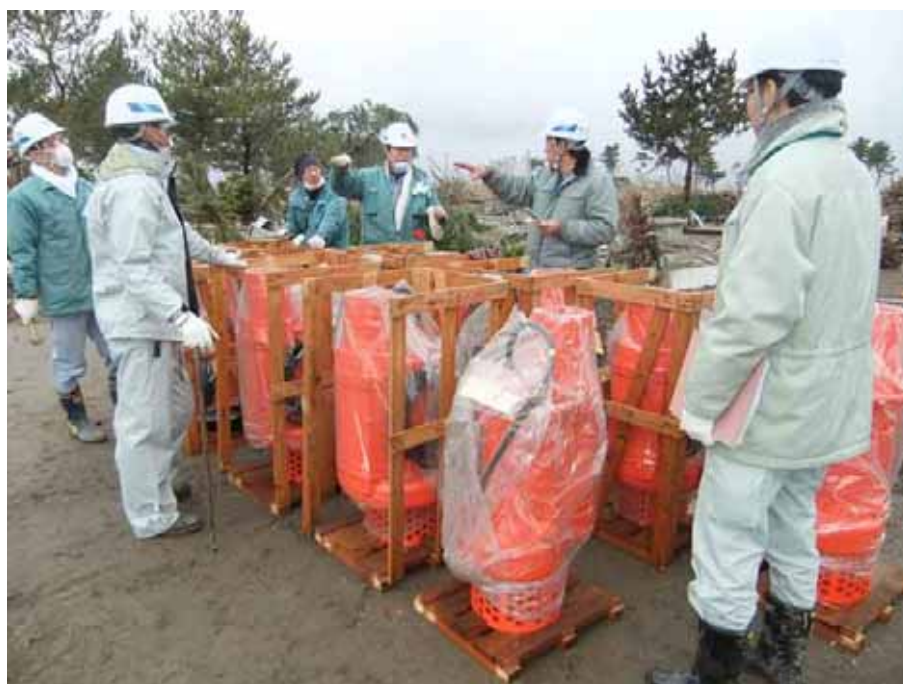
写真 2 - 2 作業状況（県南浄化センター）
