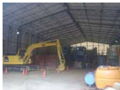
写真7 仮設脱水機施設内部
