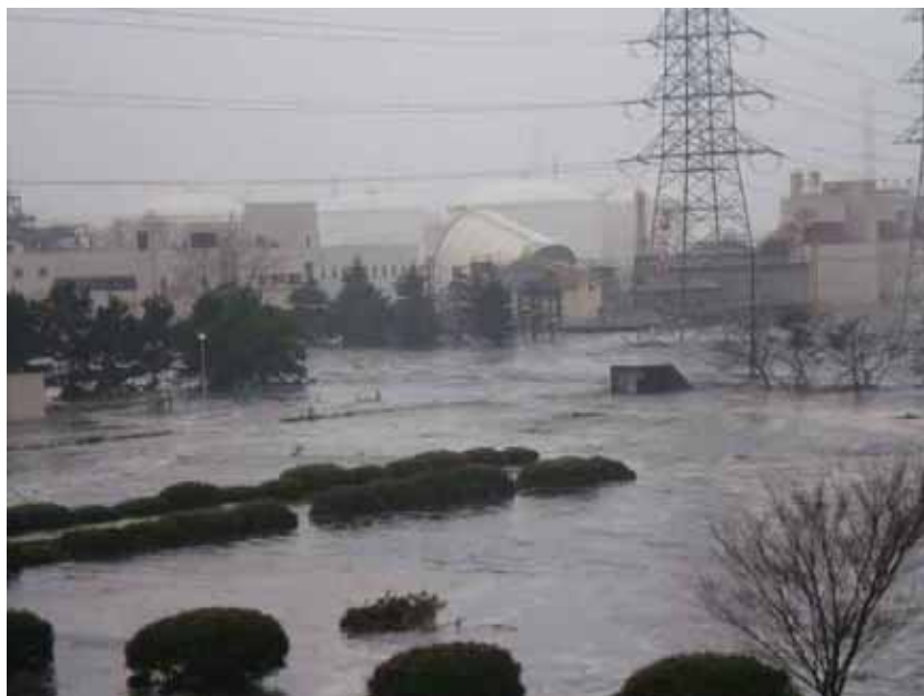
写真1-1 仙塩浄化センター 被災状況
