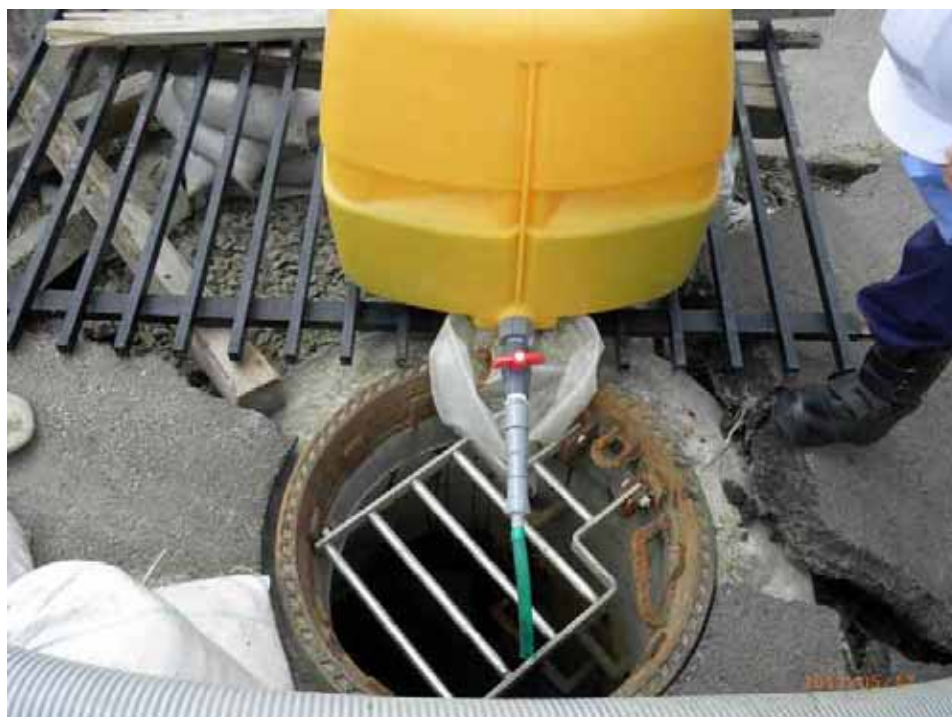
写真 2-12 県南浄化センター 塩素消毒状況
