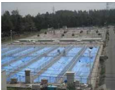
写真6 水処理系列のブルーシート覆蓋
