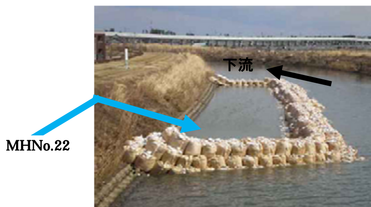
写真8 増田川仮設沈殿池
