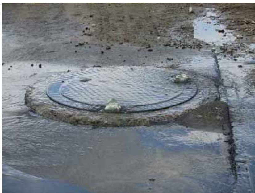
写真 1-8 マンホール溢水状況 (七ヶ浜町)
