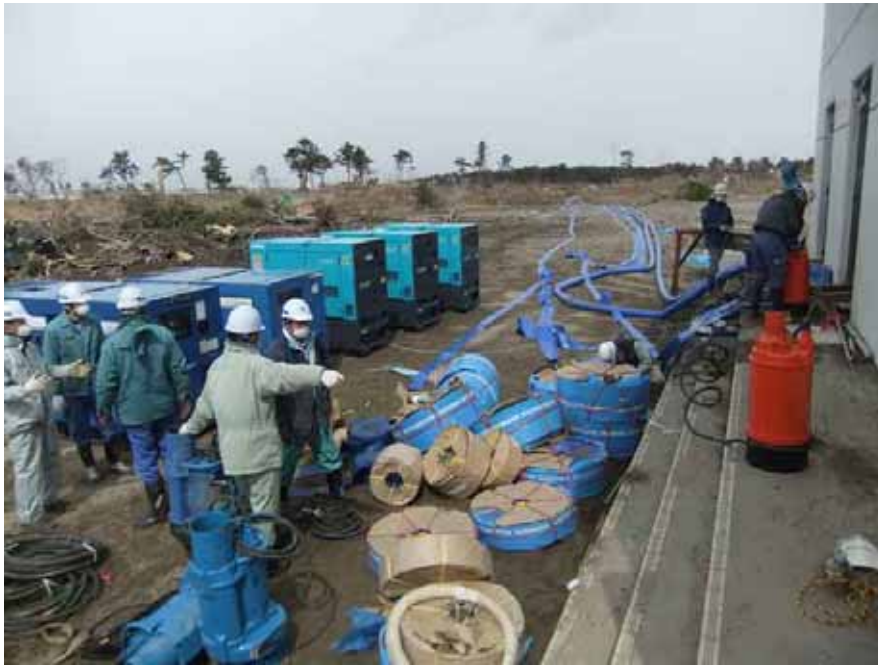
写真 2-3 作業状況（県南浄化センター）
