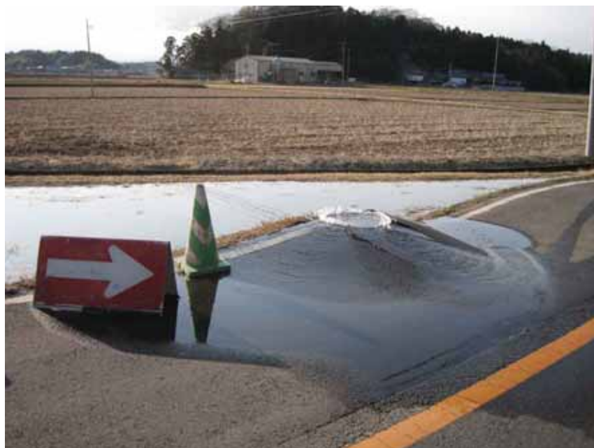
写真 1-7 マンホール溢水状況 (角田市)
