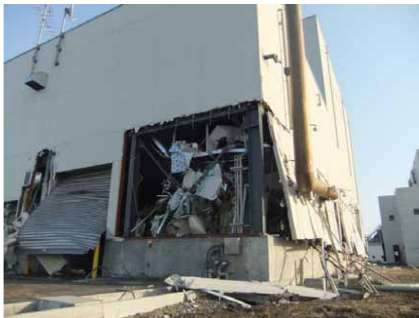
写真 1 - 4 県南浄化センター燃料化施設 被災状況
