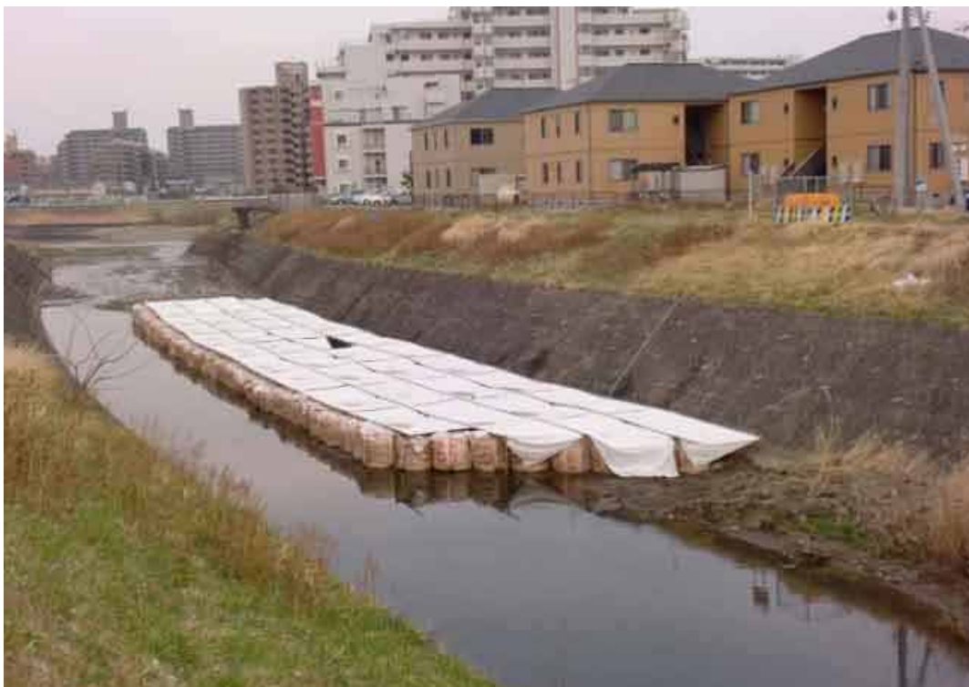
写真 2-9 要害川 仮設沈澱池
