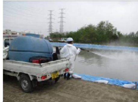
写真5 消臭剤散布状況
