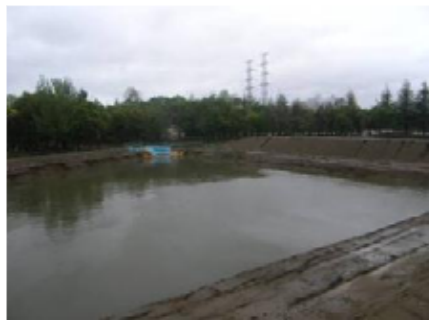
写真2 仮設沈殿池設置状況
