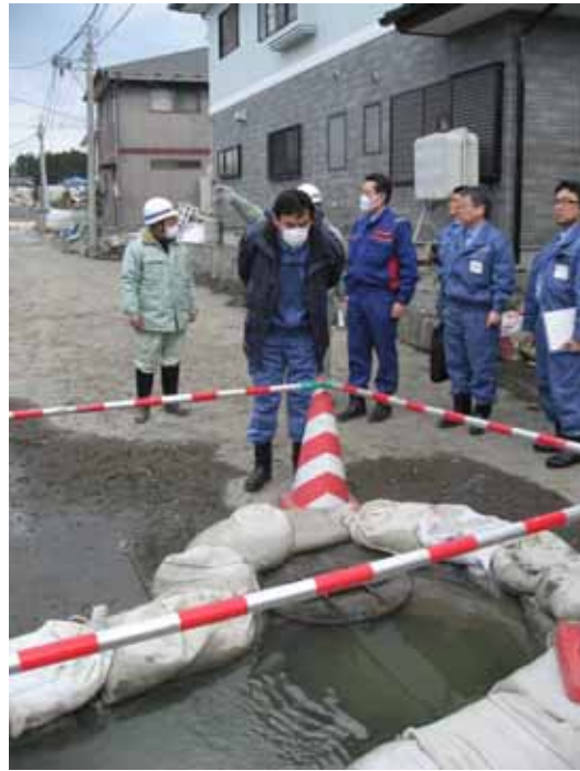
写真1-9 マンホール溢水状況（多賀城市）
