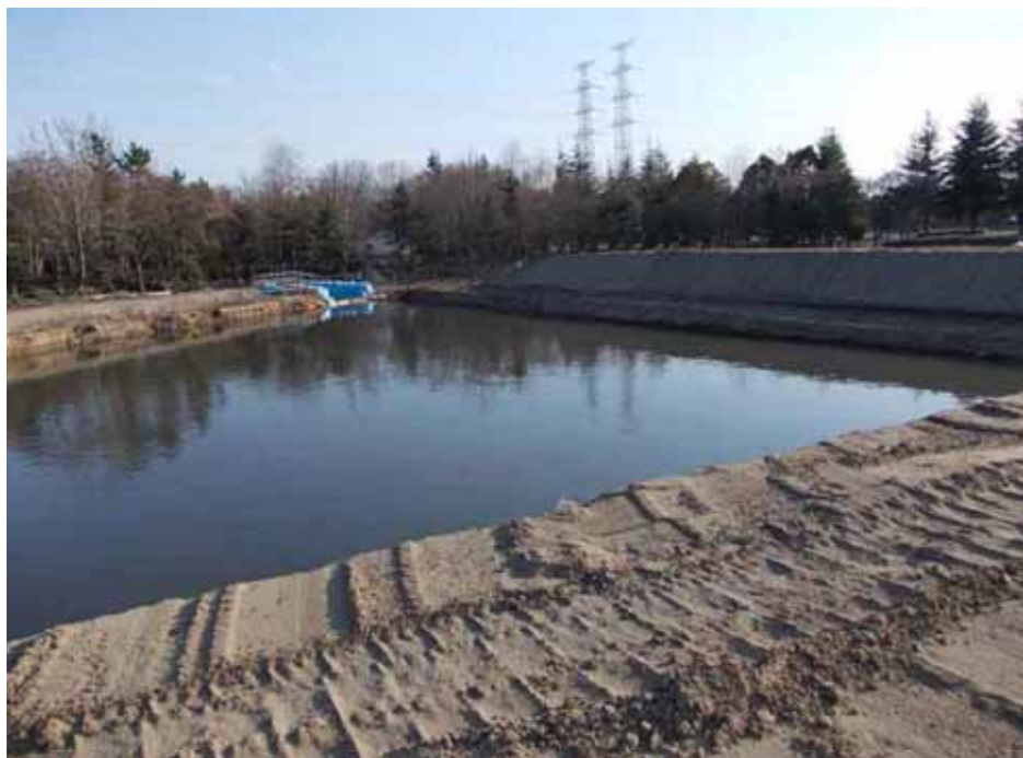
写真 2 - 7 多賀城緩衝緑地公園内 仮設沈殿池
