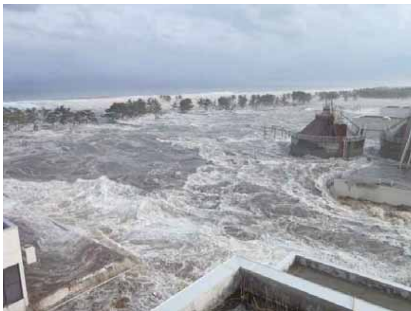
写真 1 - 3 県南浄化センター 津波到来状況
