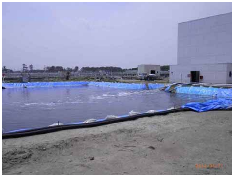
写真 2-11 県南浄化センター 仮設沈澱池
