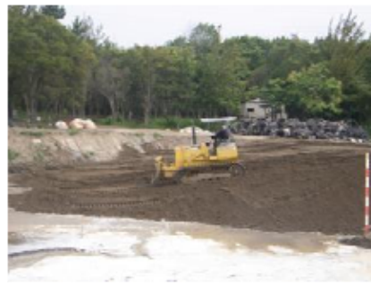
写真3 仮設沈殿池埋め戻し作業
