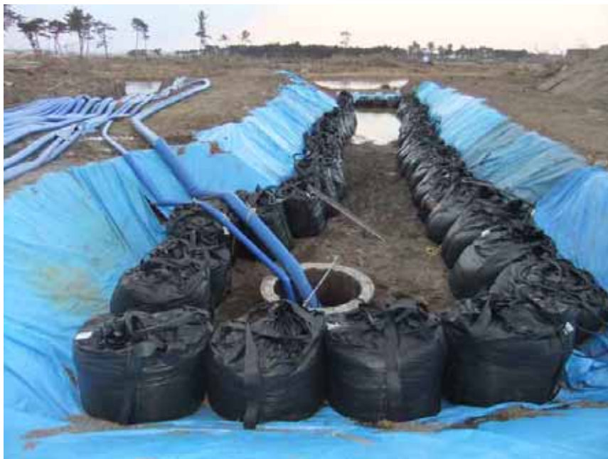
写真 2-4 緊急排水状況（県南浄化センター）
