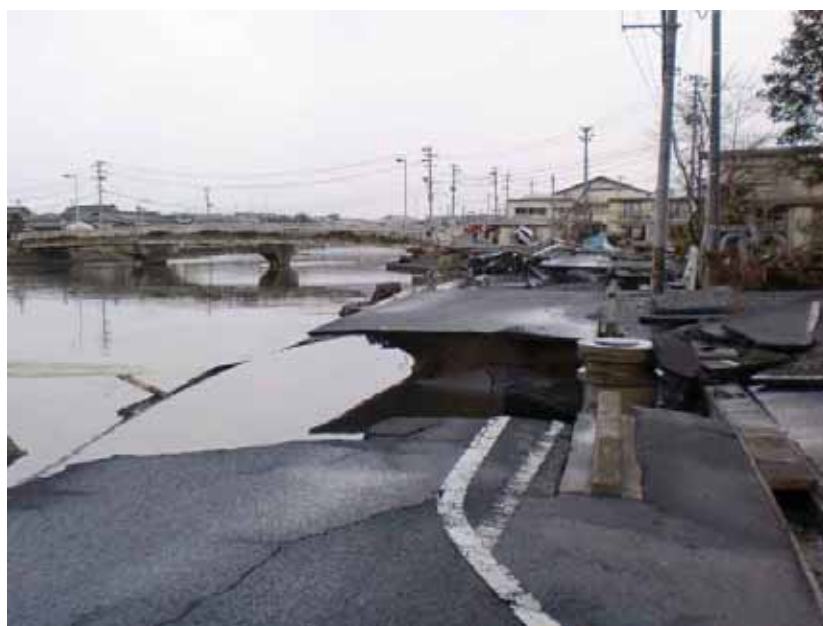
写真1-2 仙塩浄化センター 進入路被災状況
