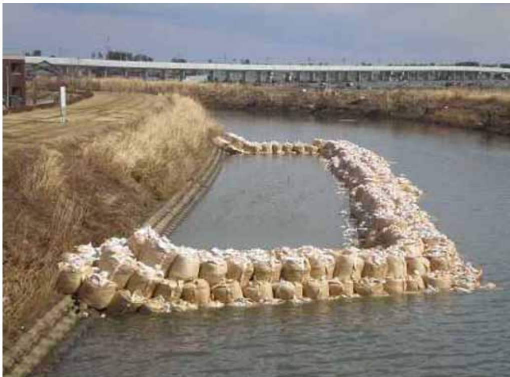
写真2-10 増田川 仮設沈殿池
