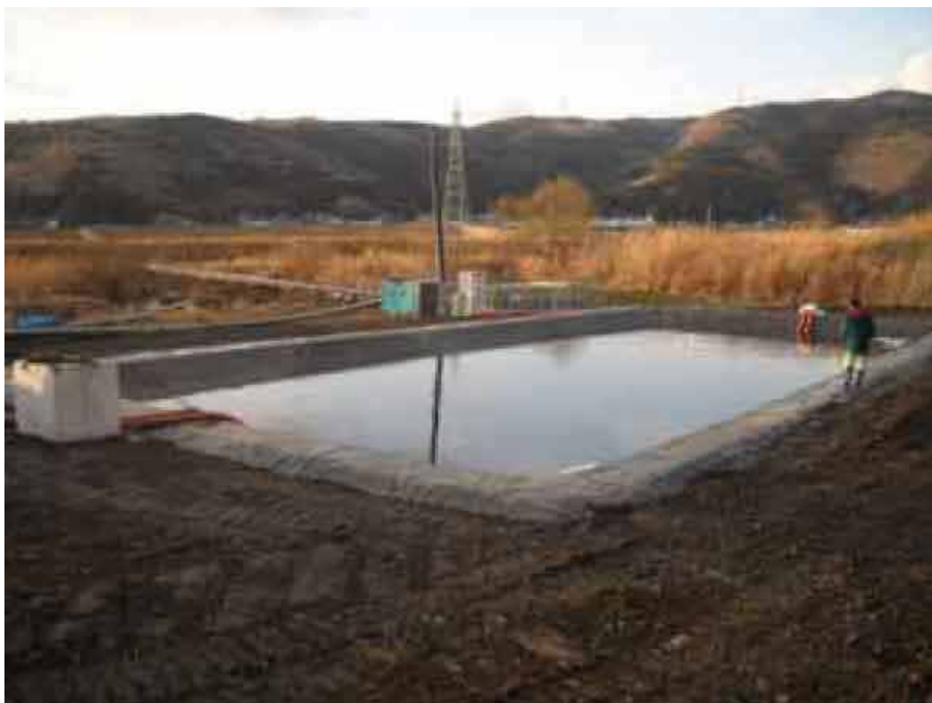
写真 2 - 1 3 真野川 仮設沈澱池
