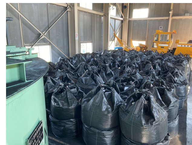
活性炭保管スペース
