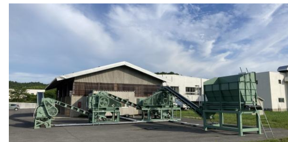
令和7年7月の工事状況
