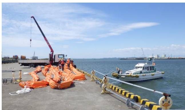
オイルフェンス展張の様子①
