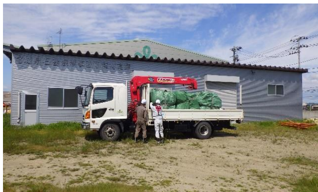
オイルフェンス運搬の様子
