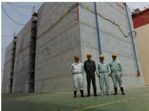
高さ16m、幅12m、長さ15m（3函）
