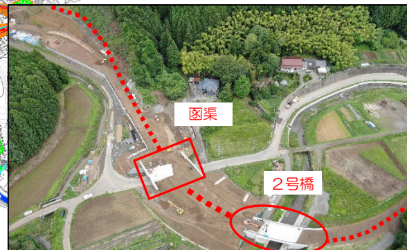
③(R3)道路改良工事(その2)
