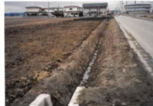
▼平成2年 PL 管設置時
