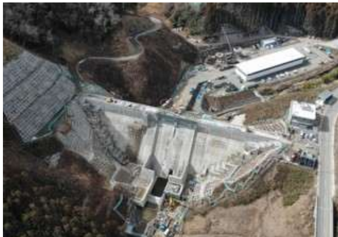
川内沢ダム 建設工事 (名取市)
