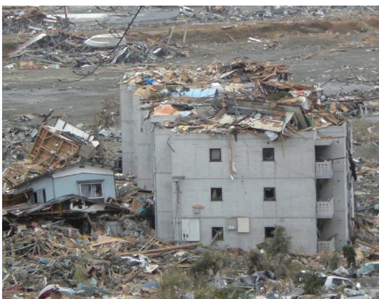
志津川廻館前住宅被災状況
