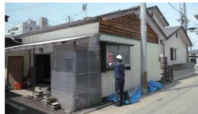
被災建築物応急危険度判定の活動状況
