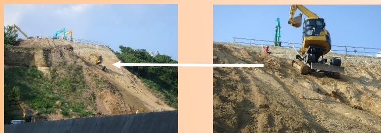
高所法面掘削機による切土施工
