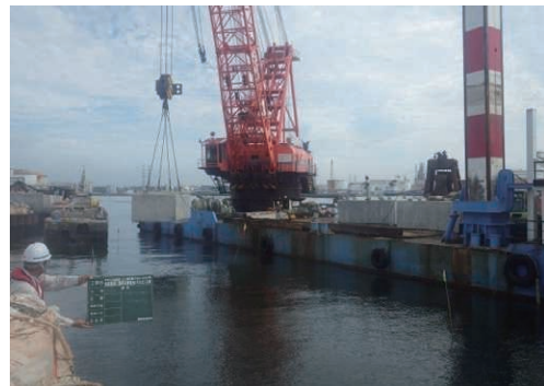
北航路西 C 護岸被災ブロック再設置工事
