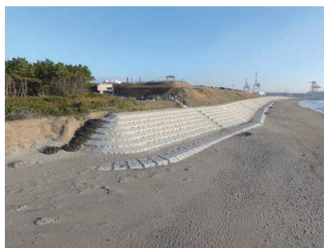
向洋地区防潮堤完成(3.23)
