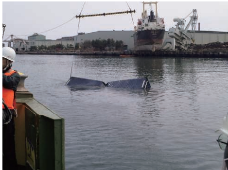
被災コンテナ撤去作業
