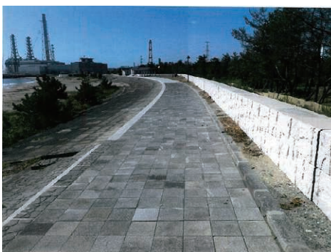
湊浜親水護岸復旧工事完了
