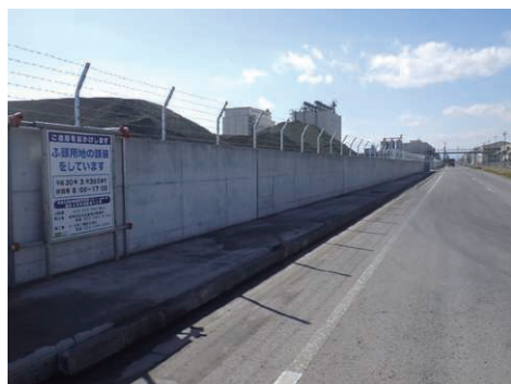
高松ふ頭防潮堤工事
