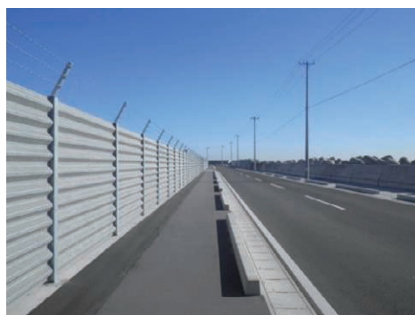
高砂コンテナターミナル SOLAS フェンス工事完了 (7.12)
