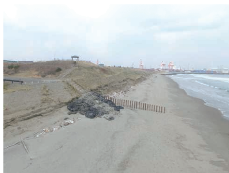
向洋地区防潮堤着工前
