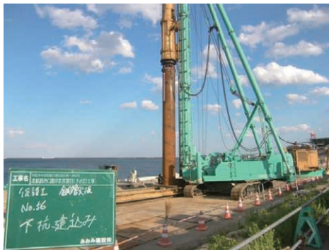
北航路西 C 護岸被災ブロック再設置工事
