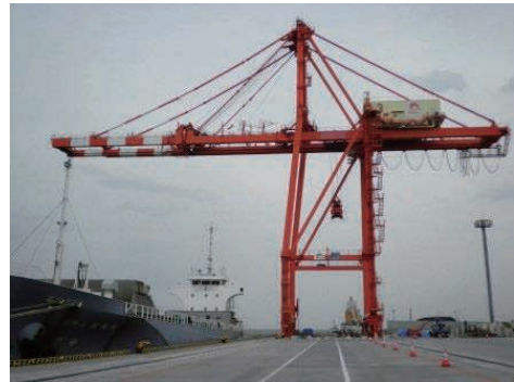
ガントリークレーン全機復旧完了 (4.28)
