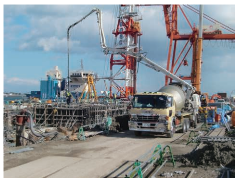
岸壁復旧作業
