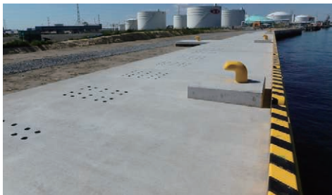
栄地区 C 護岸復旧完了 (10.5)
