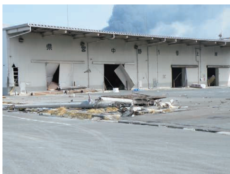
県営中野1号倉庫
