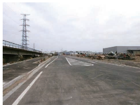
港北工業幹線復旧状況
