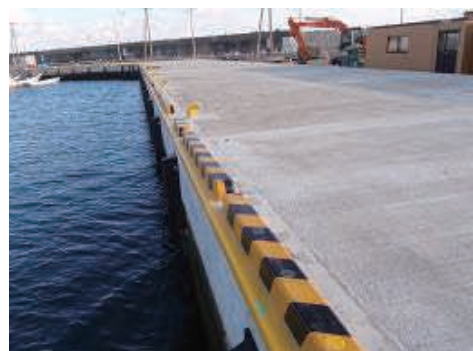
高砂船溜り復旧工事完了(3月)
