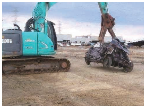
被災車両仮置状況
