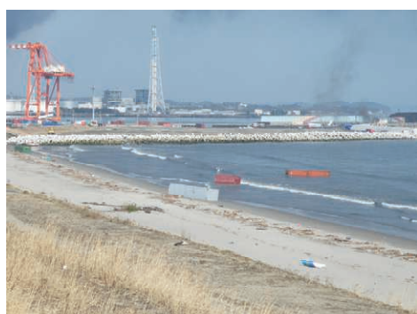
散乱するコンテナ（向洋海浜公園）
