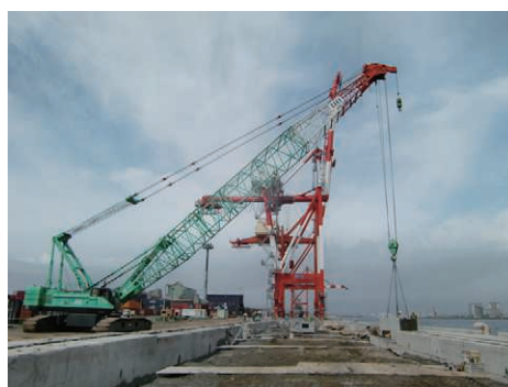
岸壁復旧作業
