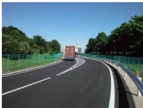
臨港道路ふ頭 8 号線新設(7.31)
