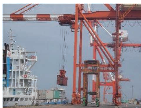
ガントリークレーン 2号機復旧 (9.5)
