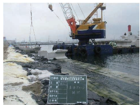
中央公園護岸（雷神護岸Ⅰ）復旧作業
