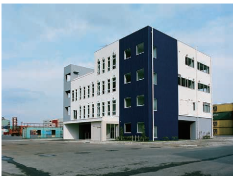
コンテナターミナル管理棟完成
