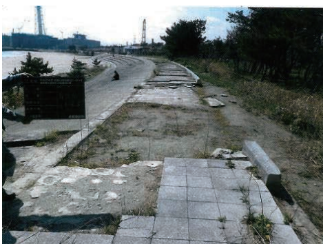
湊浜親水護岸復旧工事着工前
