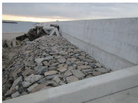
栄地区 C 護岸復旧完了 (3.20)
