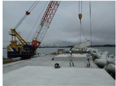
新北防波堤上部コンクリート打設(6.16)
