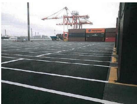
高砂ふ頭舗装完成(11.6)
