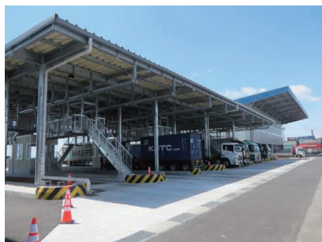
トラックゲート完成 (3.5)
