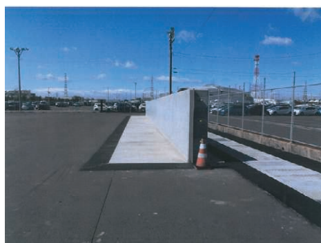
仙台港区防潮堤完成 (雷神工区)
