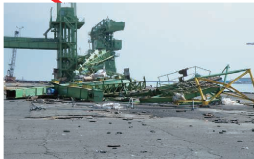
中野ふ頭 1 号岸壁 被災状況
