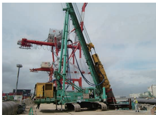
鋼管杭打ち込み
