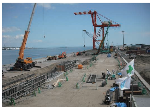
復旧工事全景
