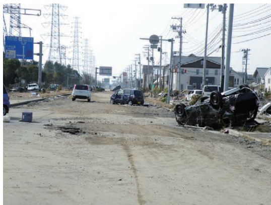
中野幹線 被災状況
