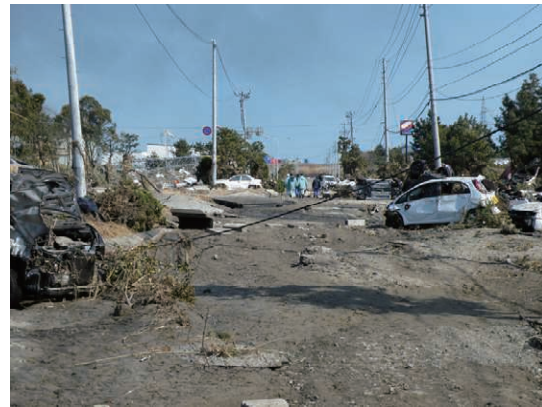
蒲生幹線 被災状況
