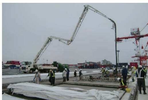
舗装コンクリート打設
