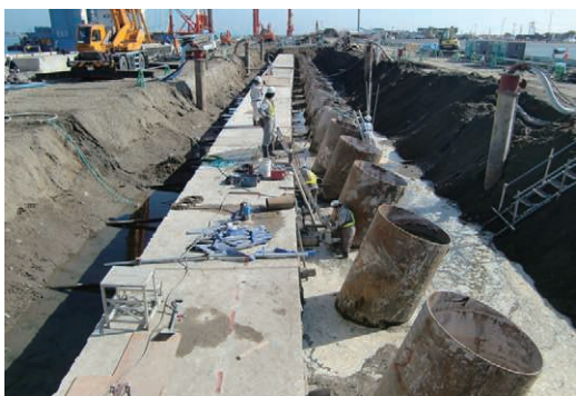
鋼管杭打ち込み完了
