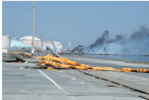
高松ふ頭岸壁 被災状況
