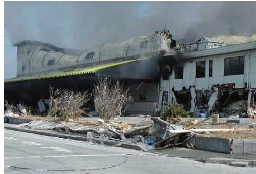
物流倉庫 被災状況
