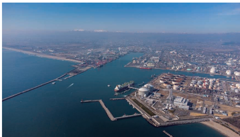
仙台港のエネルギー関連ゾーンを東側上空から望む
