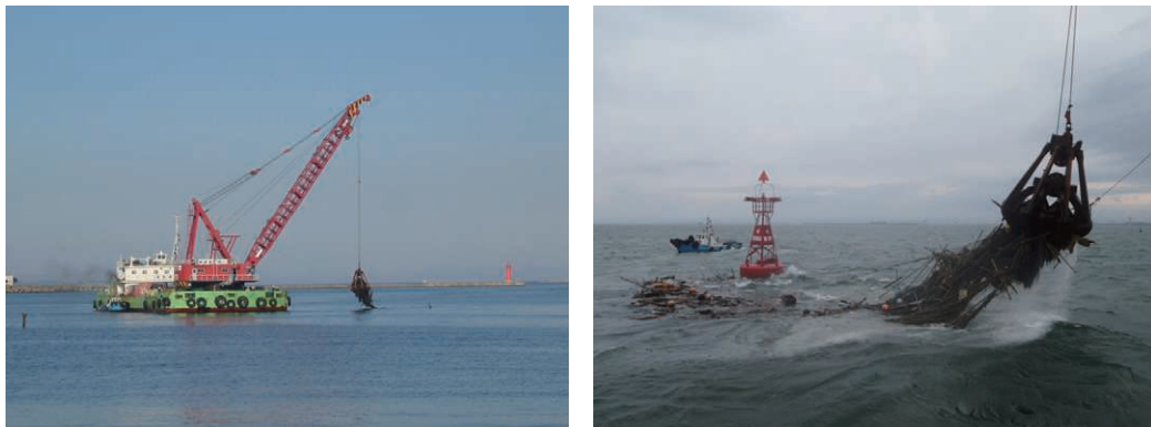
航路啓開の様子
