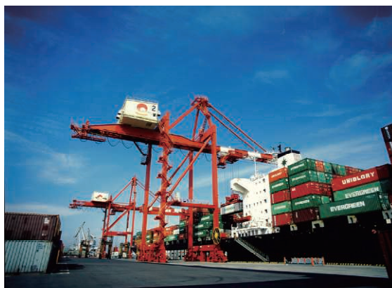
稼働するガントリークレーン （高砂コンテナターミナル）
