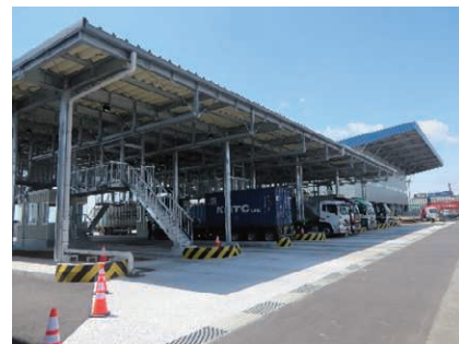
トラックゲート供用開始 (令和2(2020)年4月13日)
