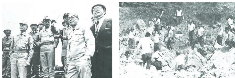
被災状況視察・復興状況
