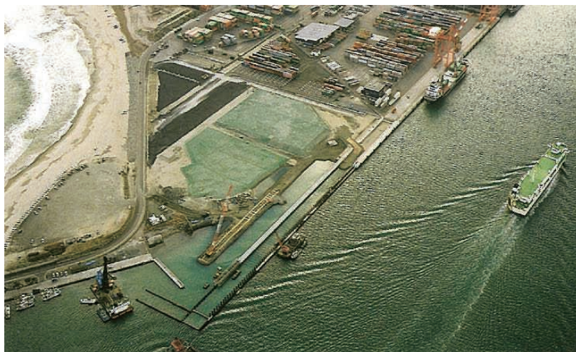
完成間近の高砂ふ頭2号岸壁(水深14m)
