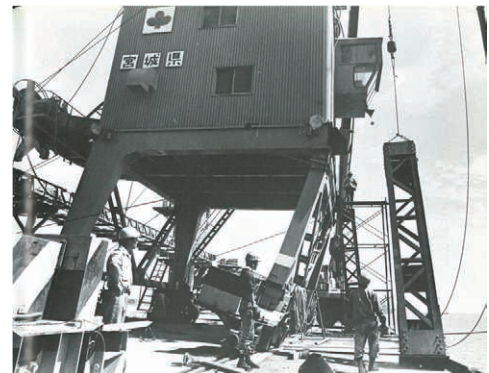
アンローダーの損傷(石巻港)
