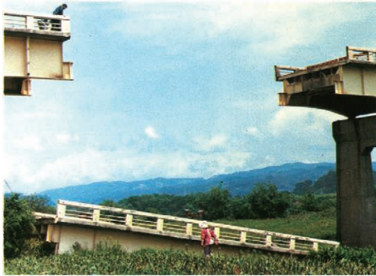
落下した錦桜橋（北上川）
