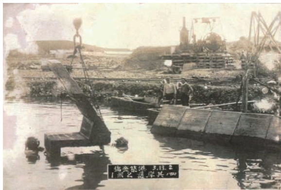
塩釜港：西ふ頭前面の護岸築造工事 昭和 3(1928)年
