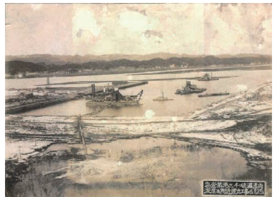
塩釜港：東ふ頭と中ふ頭に挟まれた 泊地の浚渫工事 昭和 6(1931)年
