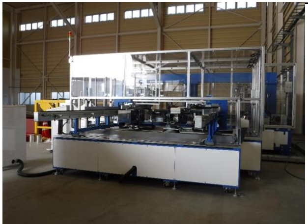
受入状況（太陽光パネルリサイクル設備）
