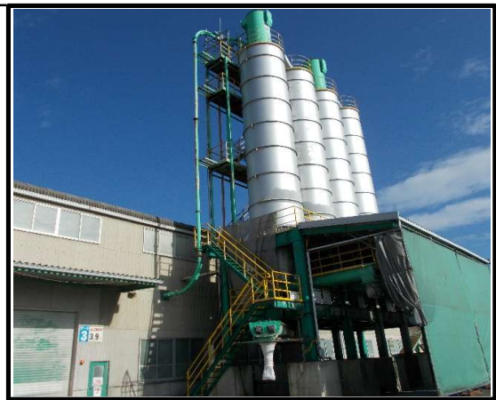
主な処理後物・製品保管施設
