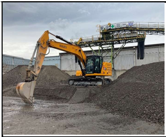
主な処理後物・製品保管施設
