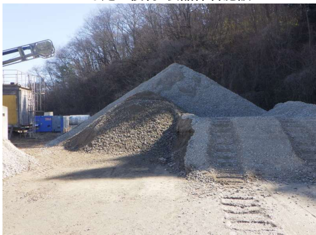
主な処理後物・製品保管施設
