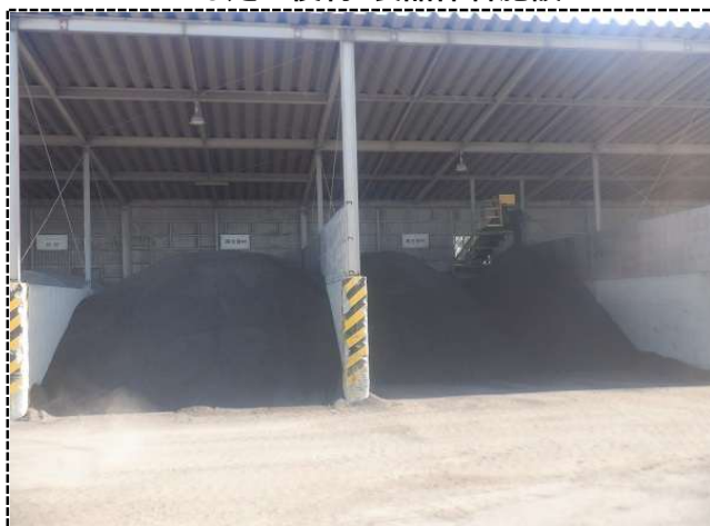
主な処理後物・製品保管施設
