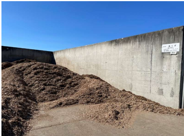
主な処理後物・製品保管施設
