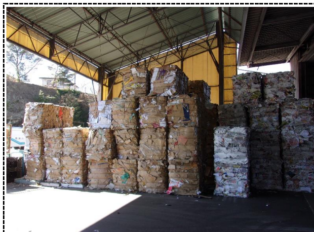
主な処理後物・製品保管施設
