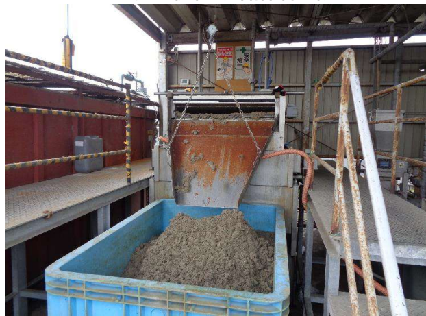
主な処理後物・製品保管施設
