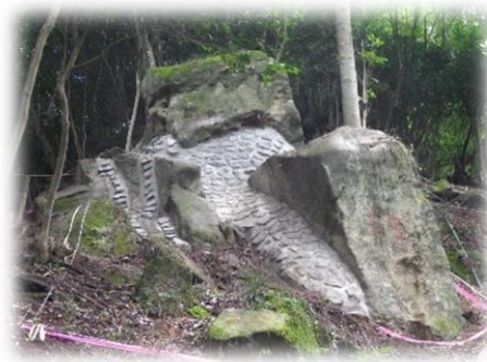
岩石着 DK ボンド工法の施工完了
