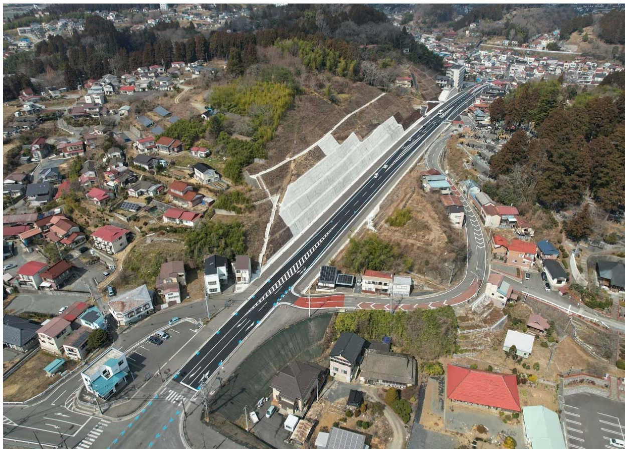
令和8年3月に完成した主要地方道気仙沼唐桑線「化粧坂道路改良工事」
