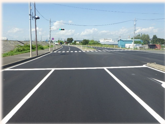
赤井舗装補修工事 【令和7年度完成】
