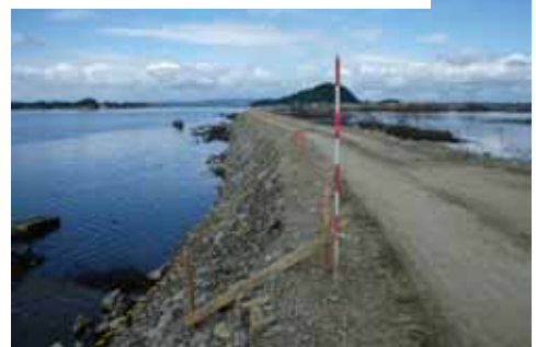
東名海岸応急仮締切工事中
