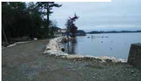
長石海岸応急仮締切完了
