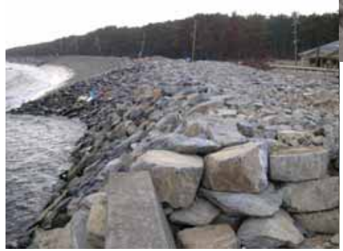
既存堤防撤去・ 応急仮締切完了
