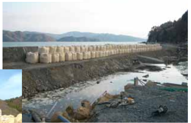
応急仮締切完了
