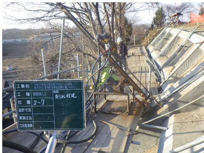
○鉄筋挿入工
