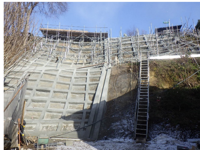
→ ○吹付法枠完成
