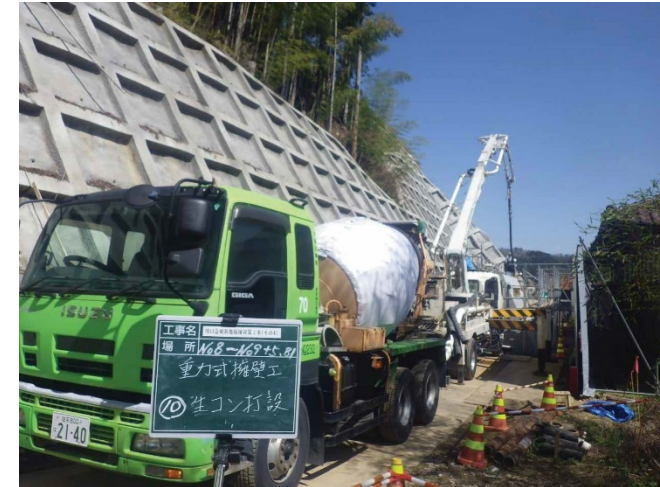
→ ○コンクリート打設・養生
