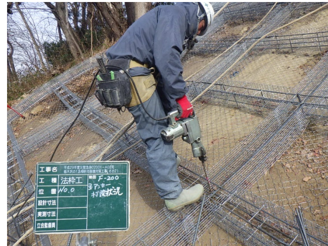
→ ○アンカー設置
