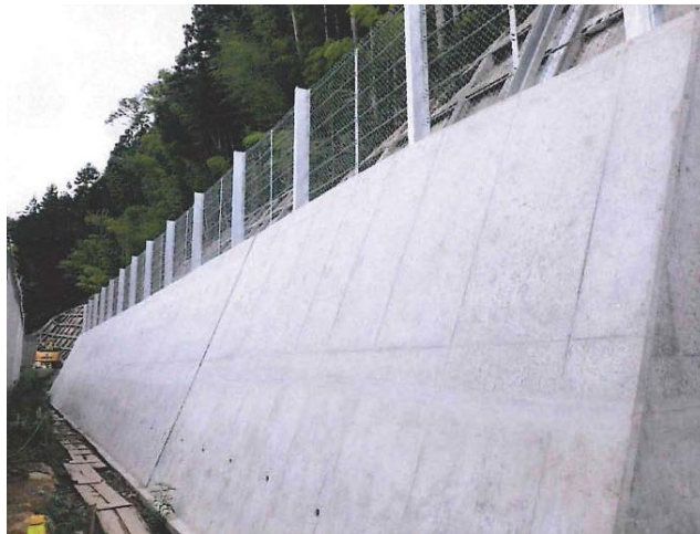
○重力式擁壁工
