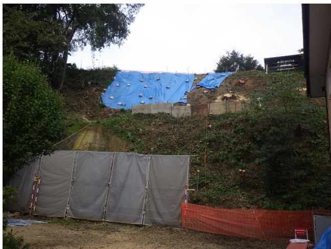
○仮設防護柵設置
