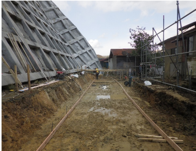
○床堀・基礎砕石設置
