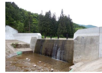
治山事業の実施 (流木捕捉施設)
