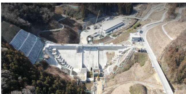
▲ダム建設（川内沢ダム）
