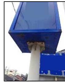
支柱・広告板接合部
