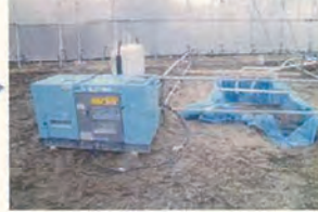
③仮設工(沈砂池・素掘側溝) 盛土施工前に、沈砂池・素掘側溝を設置
