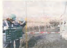
⑨. 施工深度確認
