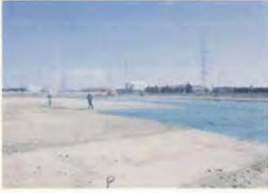
良質土による埋戻工完了後、飛散防止に種子散布を実施
