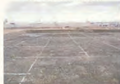
⑦. 施工エリアの明示(区画割り)
