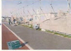
種子散布完了後、飛散防止ネットを撤去
