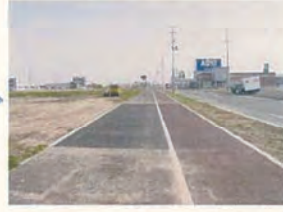
飛散防止ネット撤去完了後、工事用道路撤去・工事車両出入口撤去
