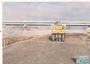
⑤盛土工(不溶化土・鉛含有量超過汚染土) センター部より搬入した不溶化土及び、鉛含有量超過汚染土を敷均・転圧
