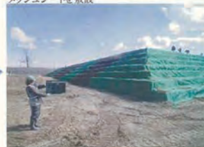
⑥仮設工(ナイロンメッシュシート) 不溶化土及び、鉛含有量超過汚染土による盛土工完了後、段切り及び、覆土との境にナイロンメッシュシートを敷設
