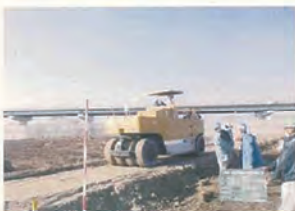
④盛土工(試験盛土) 盛土に先立ち、試験盛土を実施
