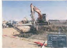
⑧. ノワーブレンダーによる施工状況
