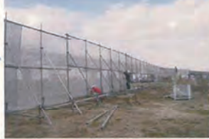
②仮設工(飛散防止ネット) 現場外周に飛散防止ネット(H=3.6m)を設置
