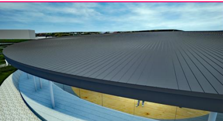
■屋根 カラーアルミ亜鉛合金メッキ鋼板 t=0.5 標準縦ハゼ
