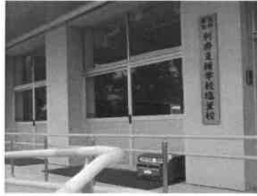
小学校の余裕教室を活用した 分校の設置 (利府支援学校塩釜校)
