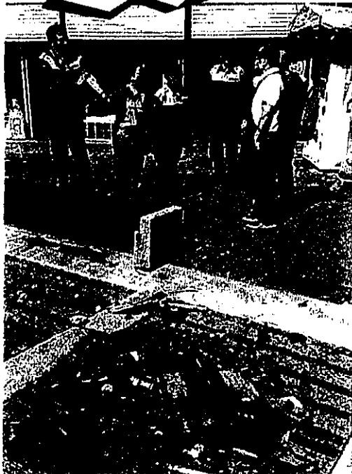
宮町の被害調査
