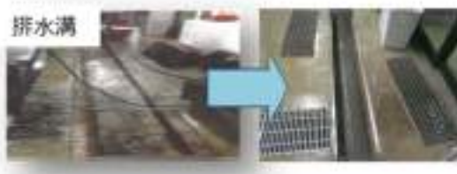
施設の衛生管理の強化に向けた排水溝、 床、壁等の改修
