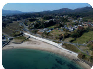
防潮堤の整備 (日門漁港海岸) 施工中
