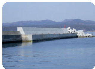
機能強化事業 泊(歌津)漁港 (泊防波堤)
