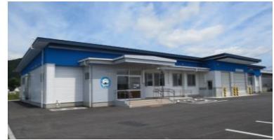
水産加工公開実験棟
