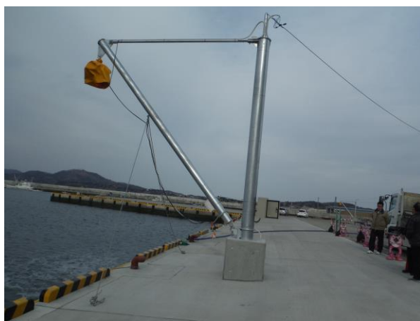
・荷揚げクレーン
