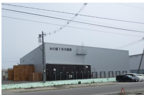
復旧した水産加工施設
