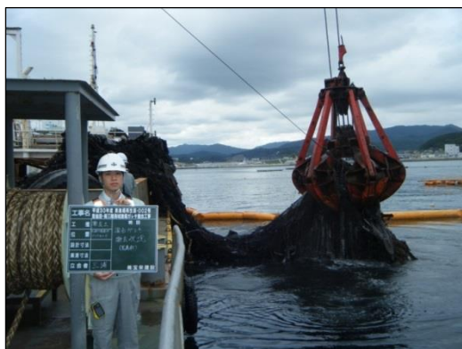
起重機船による漁場ガレキの撤去
