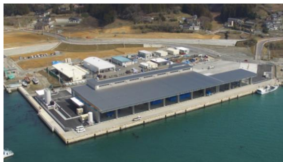
南三陸町地方卸売市場完成状況 （水産業振興課・漁港復興推進室）
