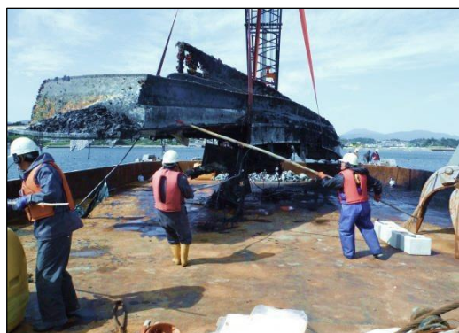
起重機船による漁場ガレキの撤去
