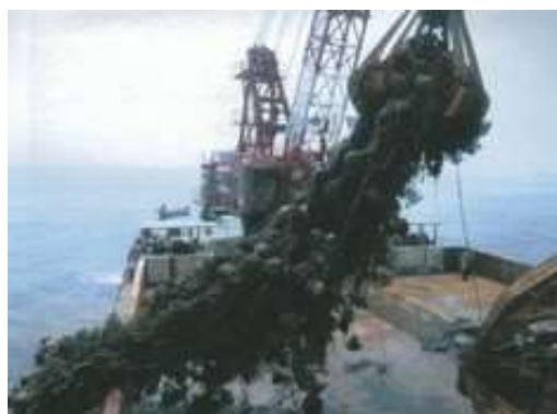
起重機船による漁場ガレキの撤去
