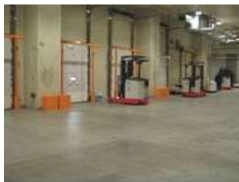
復旧した冷凍冷蔵施設
