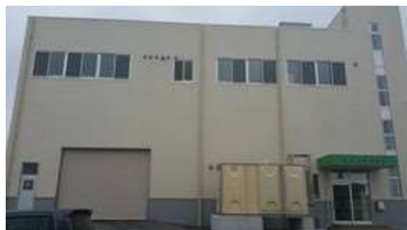
復旧した水産加工施設
