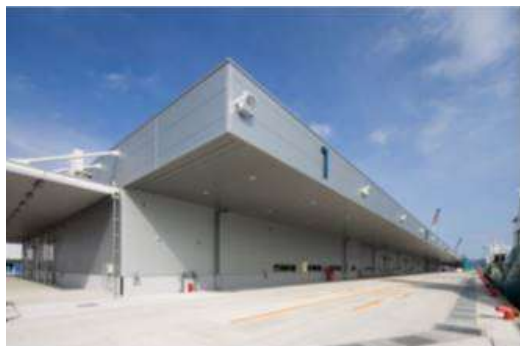
石巻漁港 石巻魚市場西棟の一部
