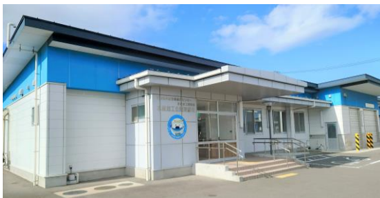
水産加工公開実験棟（石巻市）
