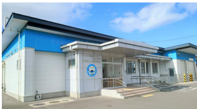
水産加工公開実験棟
